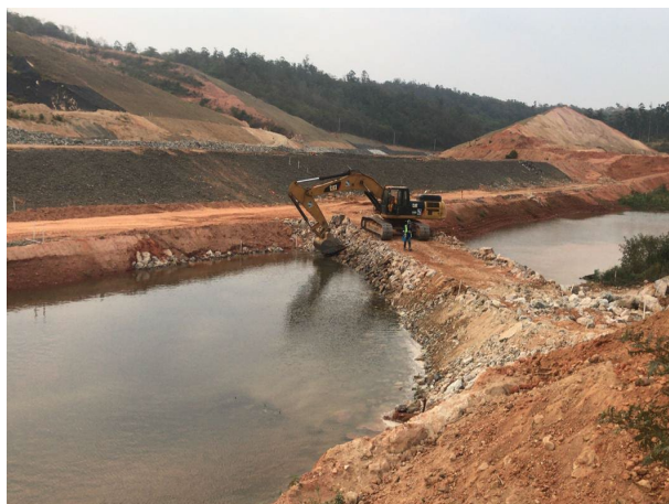
Foto 49: M1 em construção (08/10/2020)
