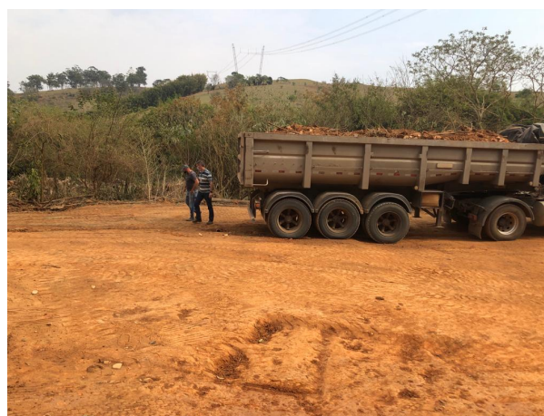
Foto 12: Remoção de Entulho pela PPC Santana (18/09/2020)
