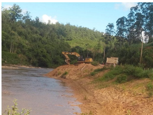
Foto 41: Construção da ensecadeira J0 (29/01/2020)
