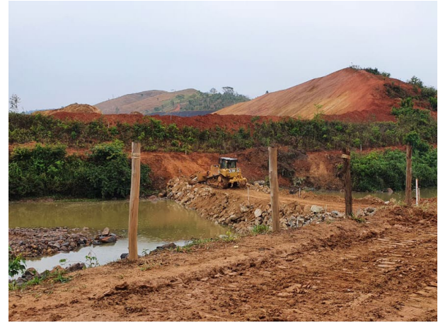
Foto 52: Construção ensecadeira J1 (15/10/2020)
