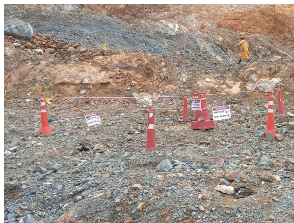
Foto 20: Área isolada para execução do Desmonte de Rochas (17/12/2020)
