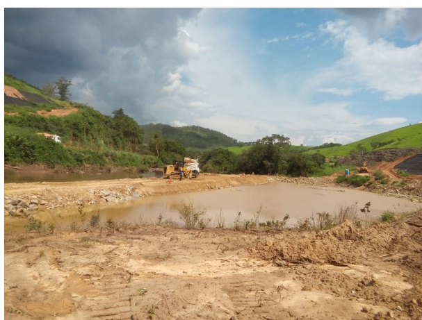
Foto 37: Construção da ensecadeira M0 (31/01/2020)
