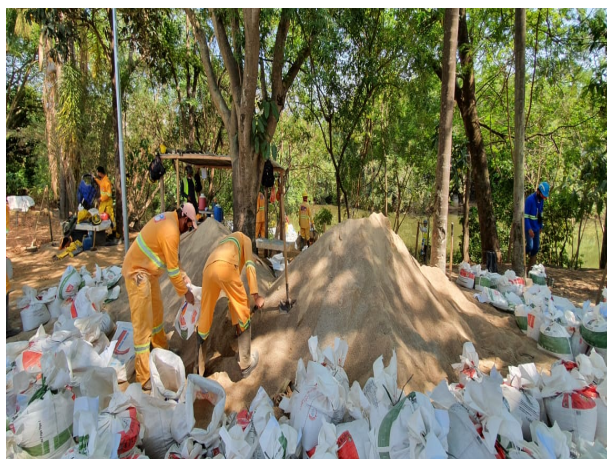
Foto 33: Construção da soleira (05/10/2020)
