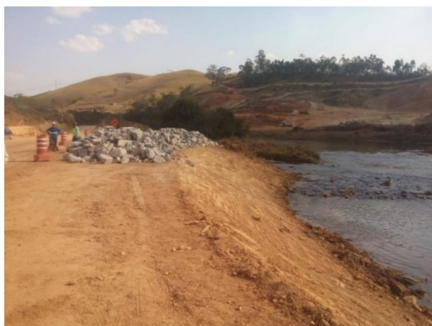
Foto 45: Pré-ensecadeira M1 em construção (30/08/2019)
