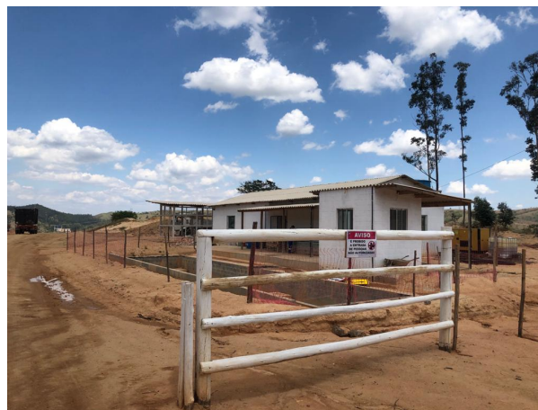
Foto 2: Situação atual das Estruturas no Canteiro operacional (21/10/2020)
