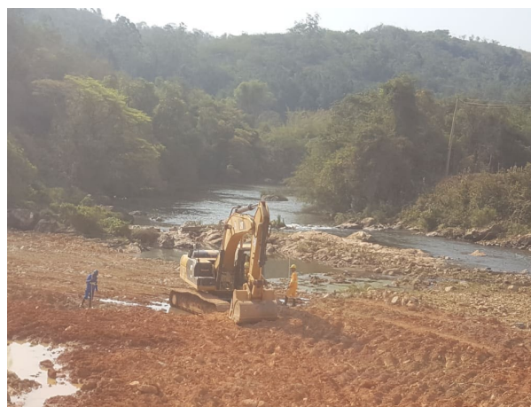
Foto 16: Remoção da enseadeira J0 para execução do Desvio do Rio Jaguari pelo canal de desvio (08/10/2020)
