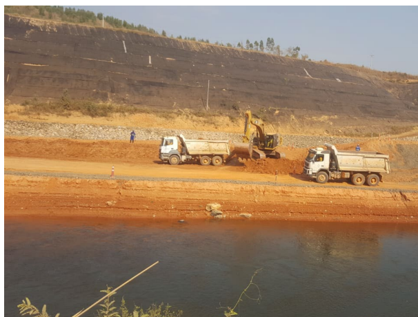
Foto 39: Retirada da ensecadeira M0 (07/10/2020)
