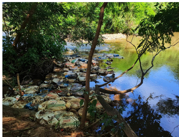
Foto 14: Soleira construída (em outubro/2020) para garantir ao SAAE o volume mínimo de água para abastecimento da população devido ao desvio do rio Jaguari (03/12/2020)
