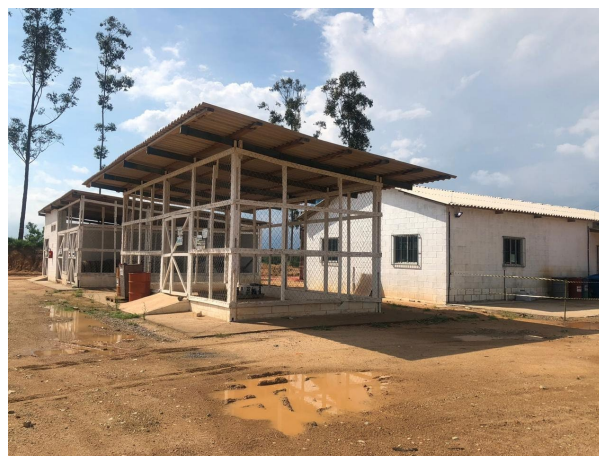
Foto 4: Situação atual das Estruturas no Canteiro operacional (22/12/2020)
