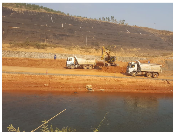
Foto 15: Remoção da enseadeira M0 para execução do Desvio do Rio Jaguari (07/10/2020)
