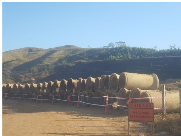
Foto 48: Manilhas removidas da M1 (06/08/2020)
