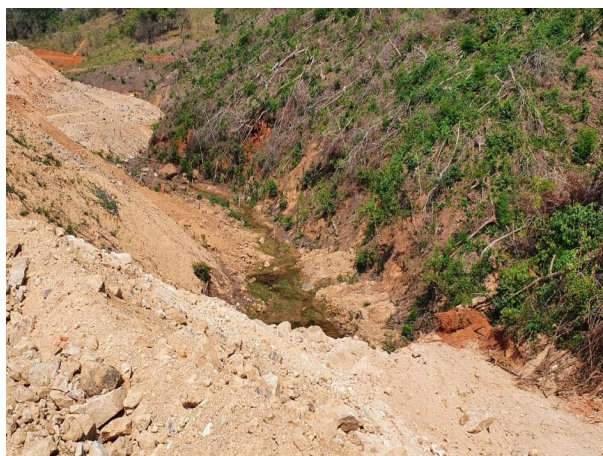
Foto 19: Expansão BF2a margem esquerda (01/10/2020)
