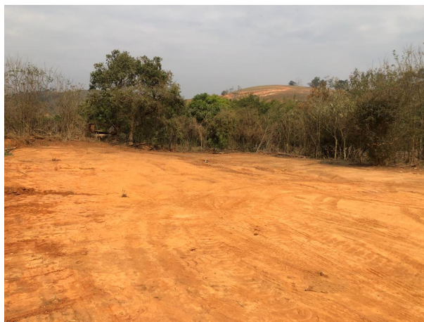
Foto 13: Finalização da Remoção do Entulho pela PPC Santana (18/09/2020)
