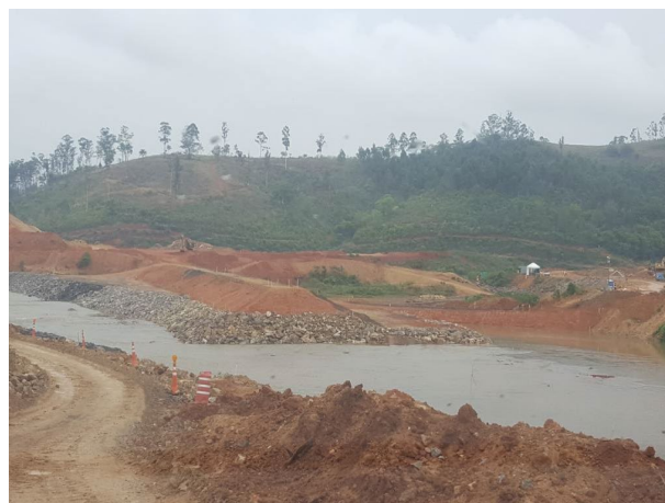
Foto 40: Retirada da ensecadeira M0 finalizada (15/10/2020)
