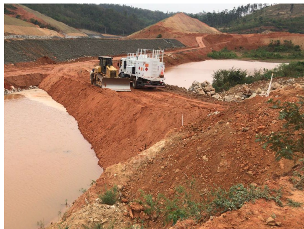
Foto 50: M1a em construção (09/10/2020)
