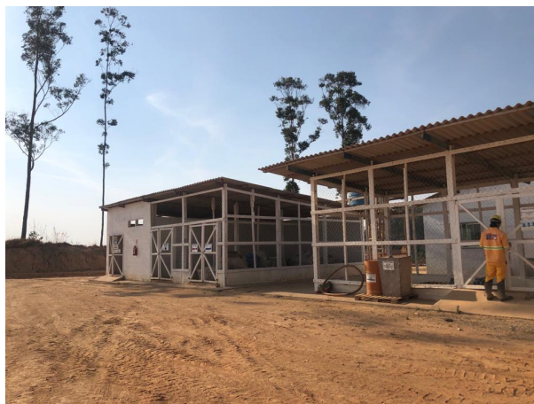
Foto 1: Situação atual das Estruturas no Canteiro operacional (16/09/2020)
