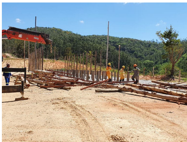
Foto 3: Situação atual das Estruturas no Canteiro operacional (17/11/2020)
