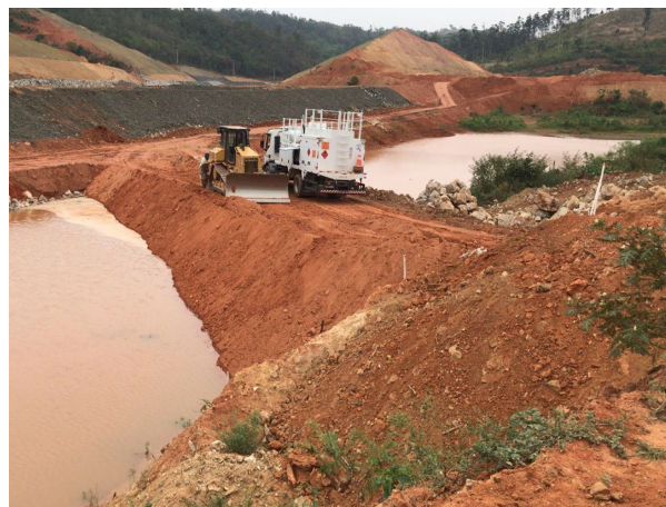
Foto 18: Construção da ensecadeira M1a para execução do Desvio do Rio (09/10/2020)
