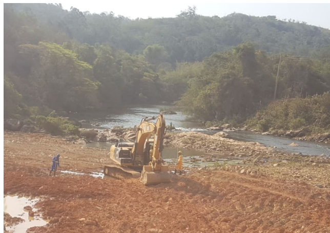
Foto 44: Retirada da ensecadeira J0 finalizada (08/09/2020)
