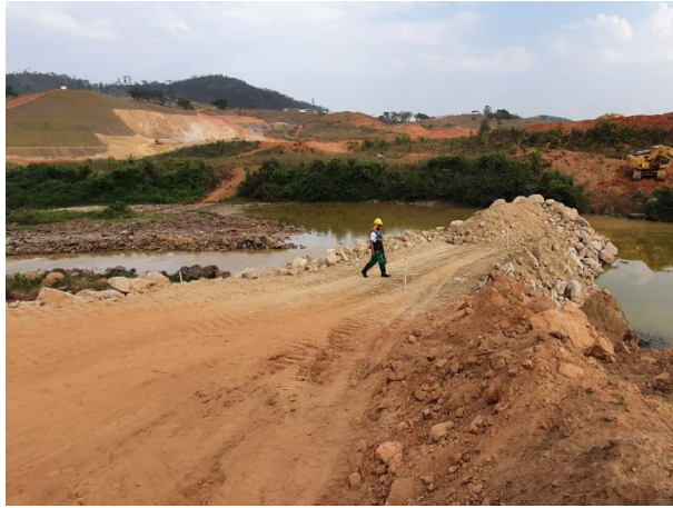
Foto 51: Construção ensecadeira J1 (13/10/2020)
