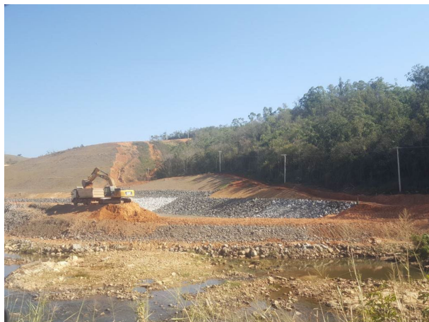
Foto 43: Retirada da ensecadeira J0 (08/09/2020)
